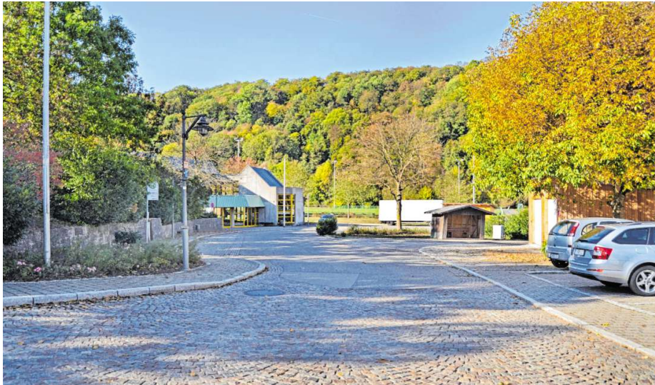
Blick von der Oberstettener Straße auf die Sporthalle (links hinten). In diesem Bereich wird der neue Zentrale Omnibusbahnhof entstehen. Dafür muss die Mauer vor der Sporthalle ein Stück zurückversetzt werden.
